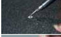
Нанести **AKELUX** Грунт для улучшения адгезии между камнем и ремонтным материалом. Время высыхания 1 минута.
